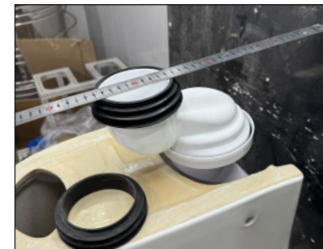
Instalación para 220-300 mm (Adaptador 1 + Adaptador 2)
