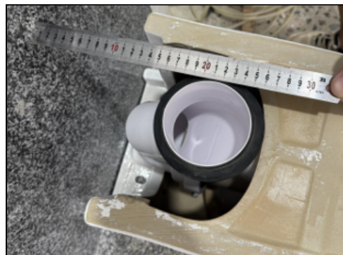
Instalación para 220 mm (solo adaptador 1)
